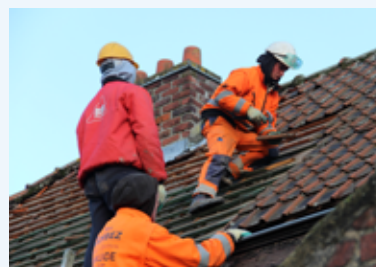
Voorbeeld van het "klinken" van dakpannen bij demontage
