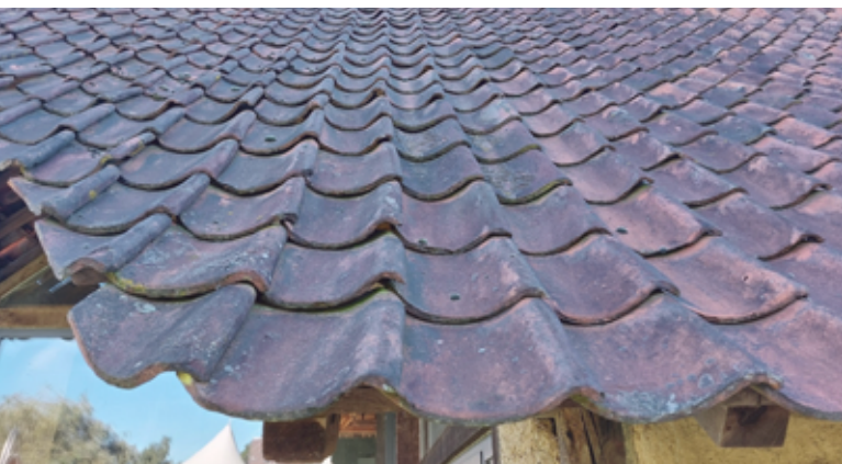
Voorbeeld van toepassing van recuperatiepannen, illustratie van de geringere maatvastheid, met impact op de esthetiek (rechte lijnen soms moeilijker te realiseren).
