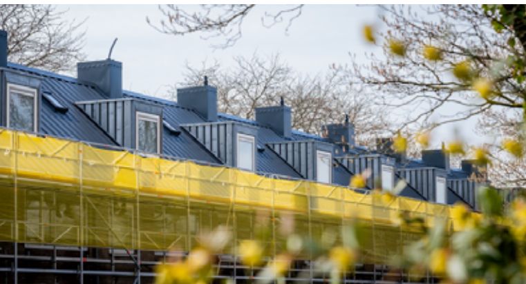
Een ander voorbeeld van creatief hergebruik : dakkapellen vervaardigd o.b.v. gerecupereerde vensters, met een bekleding in zink o.b.v. gerecupereerde dakgoten 30
