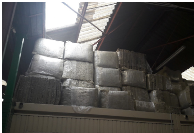
Opslag van minerale wol van binnenwanden, voordat deze opnieuw wordt geplaatst als isolatie van hellende daken
