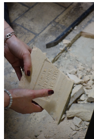
La réalisation d'un inventaire préalable et de tests de démontage permet de confirmer le potentiel de récupération des lots visés.
