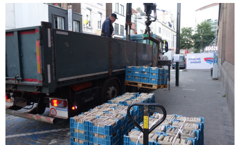
Exemples de conditionnement des matériaux. Leur agencement doit permettre qu'ils soient déplacés sans s'abîmer.
