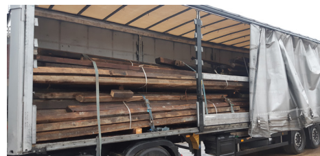
Parmi les lots récupérés lors de ce marché de démolition/curage, des carreaux de carrelage et des charpentes en bois ont été démontés soigneusement par l'entreprise. Ces matériaux ont été remis en circuit via des revendeurs spécialisés.
